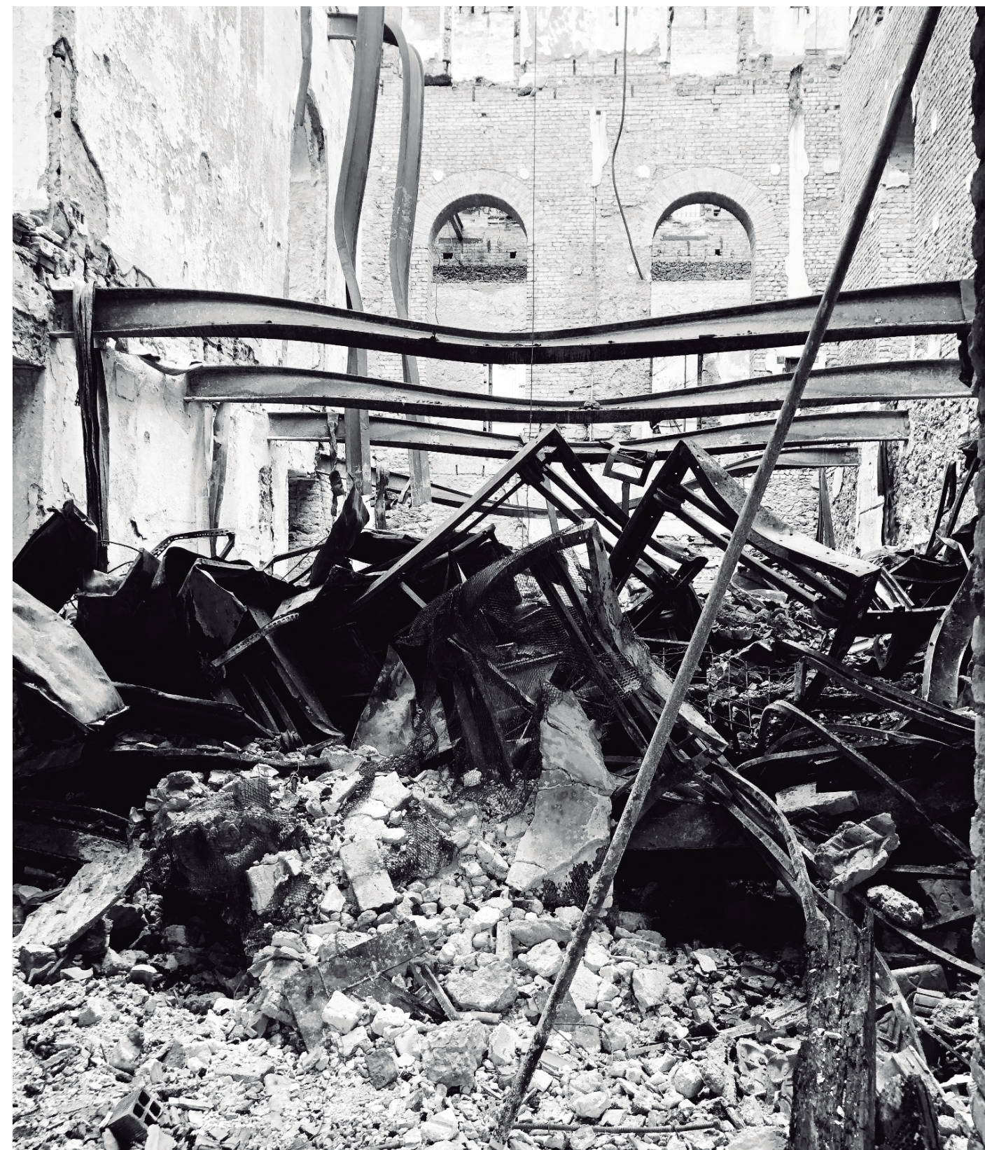
Sala do andar térreo utilizada como auditório, local onde o incêndio começou. Note as vigas metálicas retorcidas devido ao calor intenso. Foto: Acervo Resgate.
